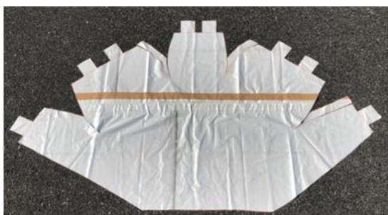
「写真 1 型枠の切り出し」
